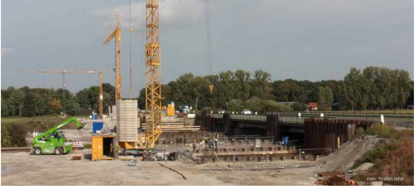
Die Baustelle der B 55-Lippebrücke.
