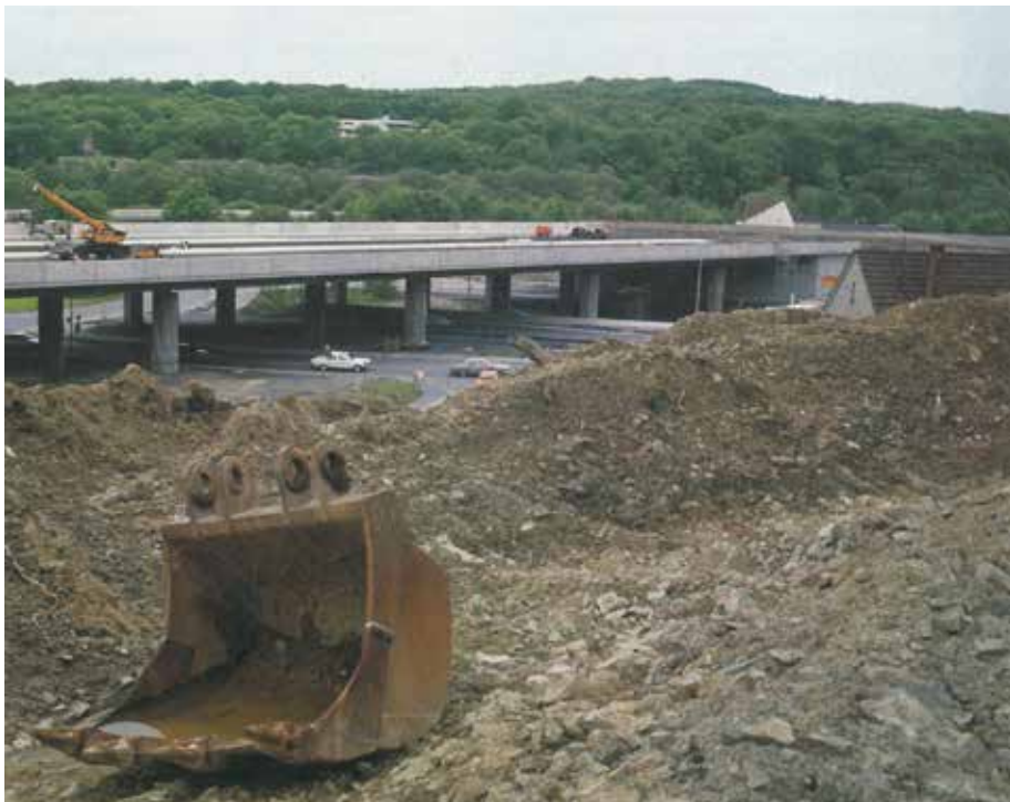
Ein weiterer wichtiger Schritt des bedeutenden Weiterbaus der Autobahn 46: Im Jahr 1984 wurde am damaligen „Trauring“ in Neheim die neue Autobahnbrücke für die A 46 gebaut.
